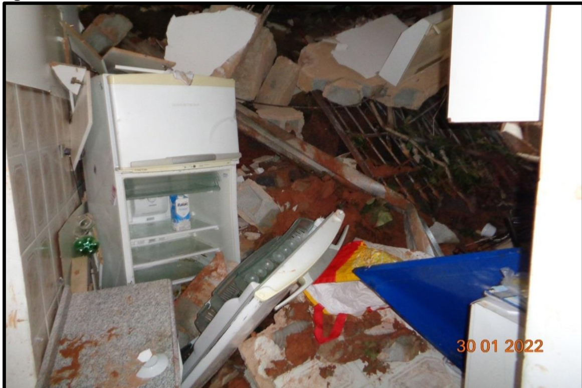
Figura 2 – Deslizamento de terra em residência.
