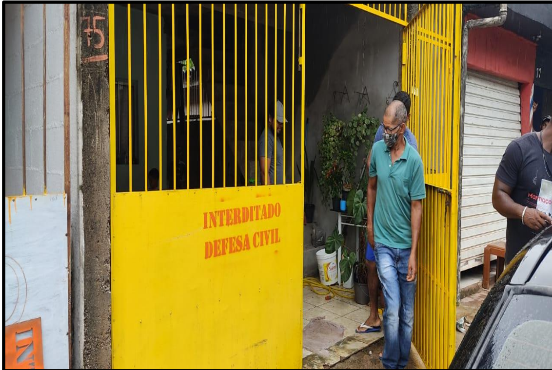
Figura 11 – Interdição de Moradia no Jd. São Camilo.
