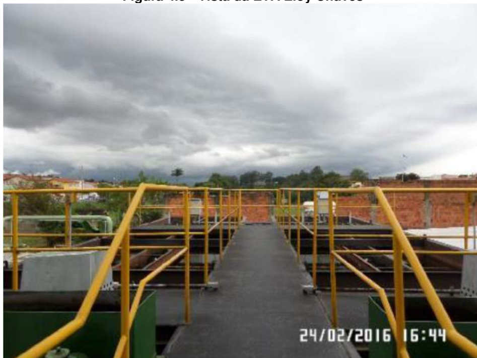
Figura 4.5 - Vista da ETA Eloy Chaves
