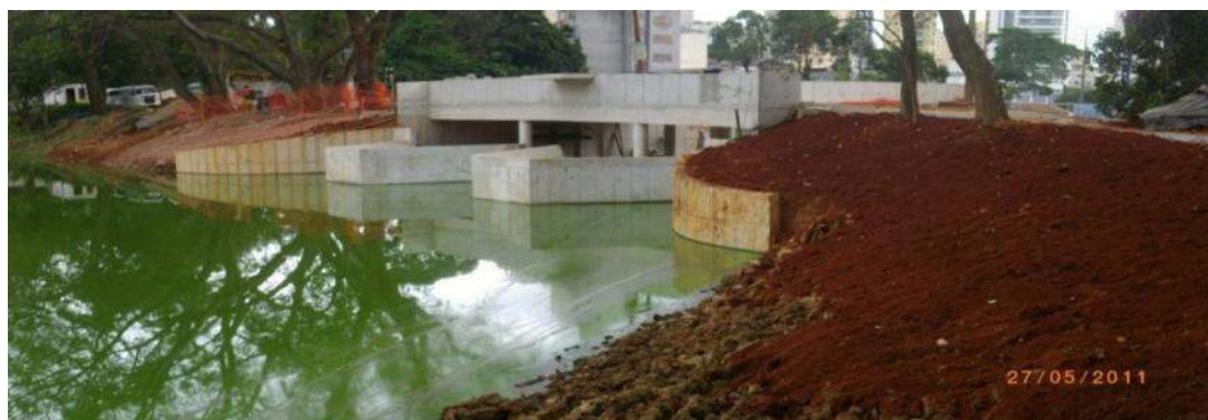
Figura 7.24 - Vertedor Labirinto no Lago da Aclimação
