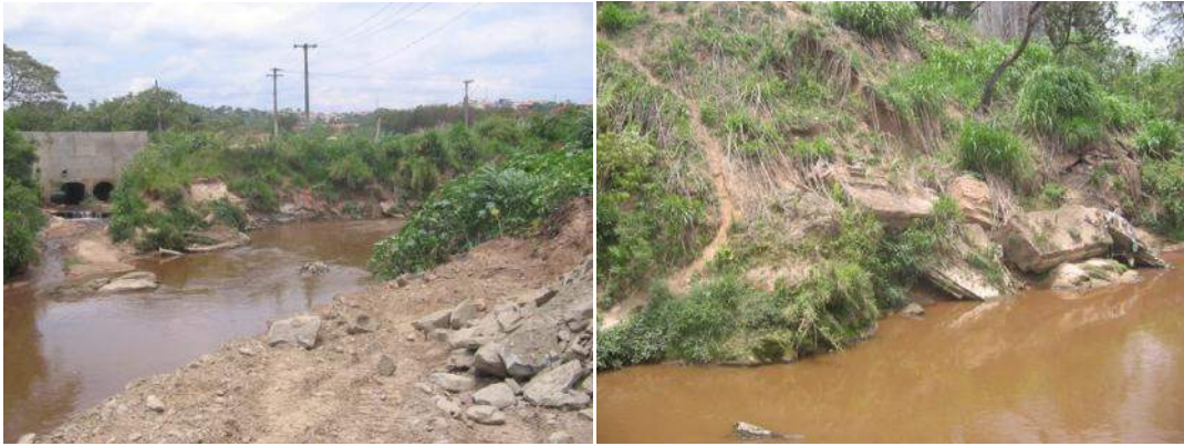
Figura 6.3 - Rio Jundiá – Presença de assoreamento, entulho e deslizamentos
