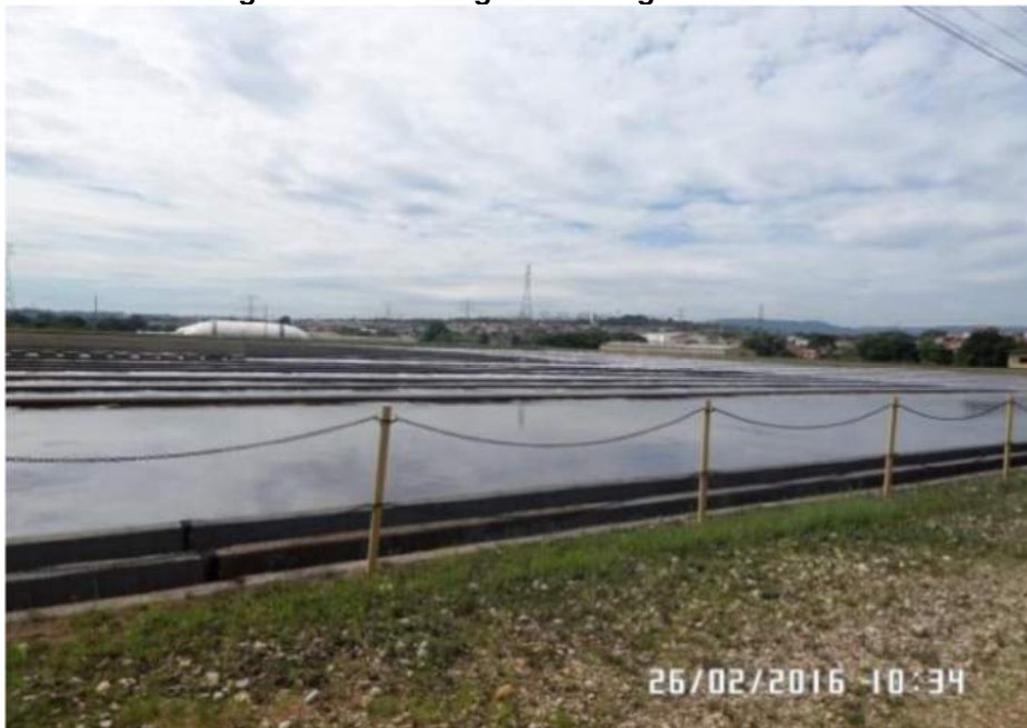
Figura 4.15 - Vista geral das lagoas aeradas
