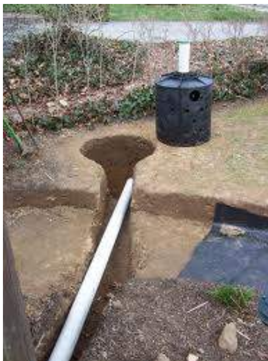
Figura 7.14 – Poço seco em construção
