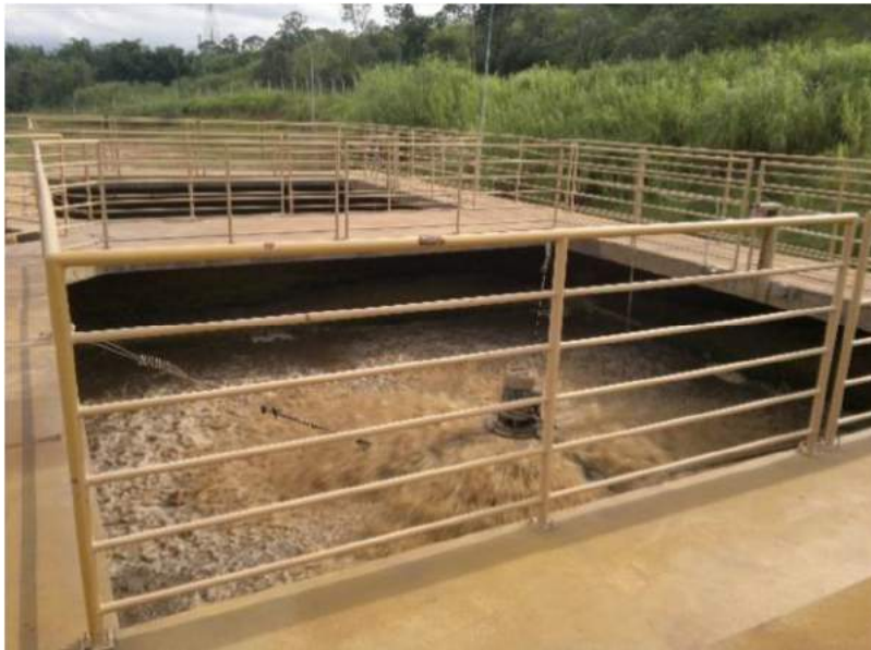
Figura 4.18 - Tanques de aeração da ETE Fernandes
