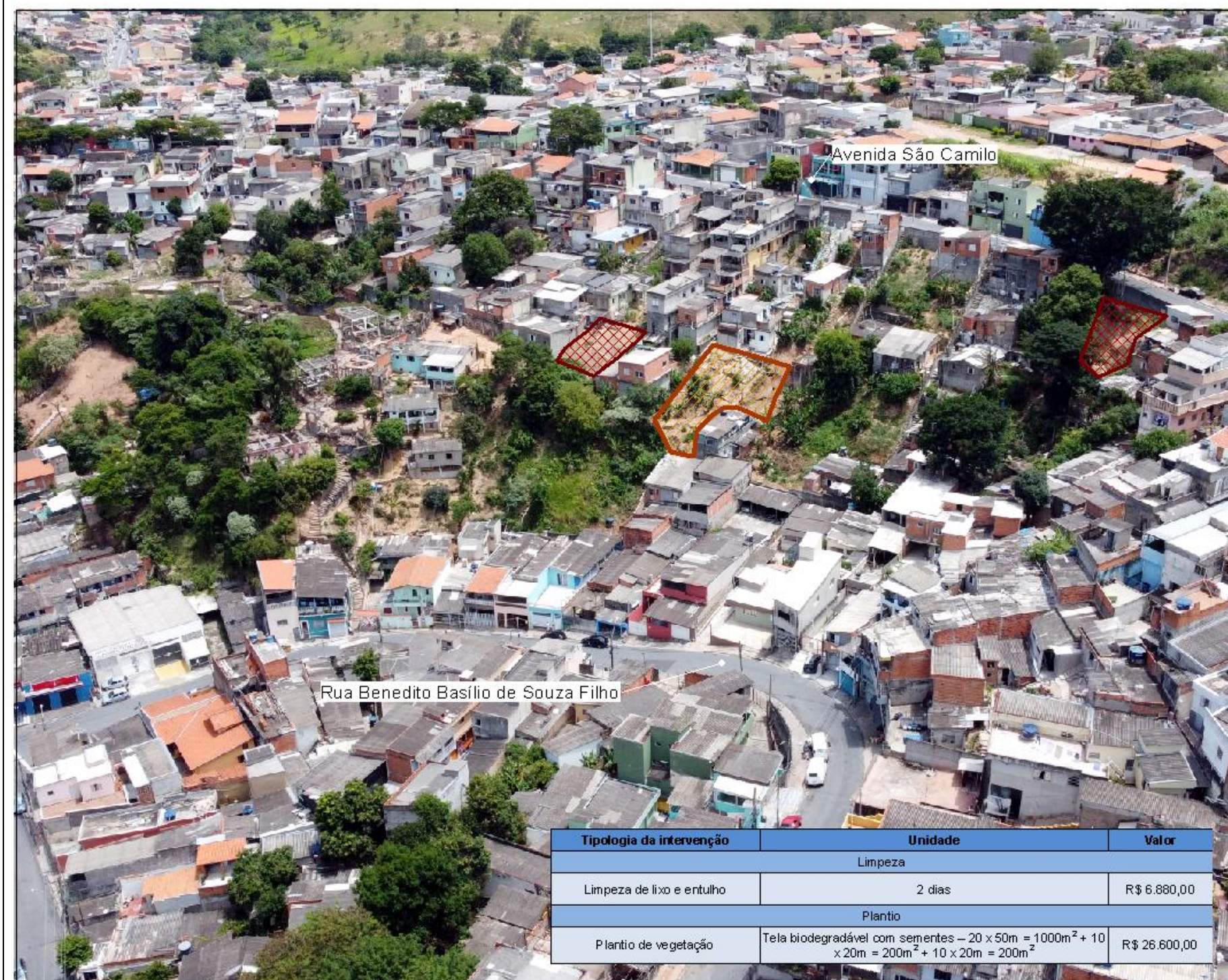
Figura 89 – Localização da intervenção estrutural e a sua tipologia em imagem oblíqua de Drone.
