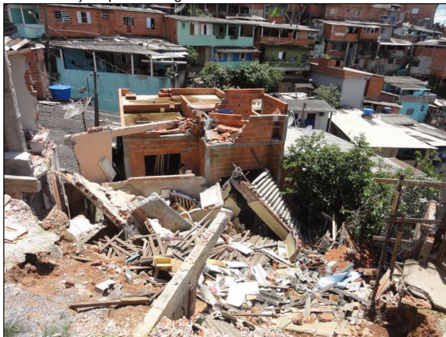
Figura 67 – Destroços da moradia que colapsou. Notar a moradia em construção que foi atingida.
