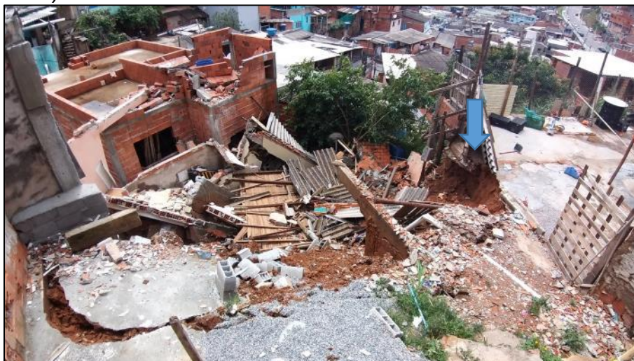
Figura 69 – Notar na lateral o material do talude de aterro (Seta Azul).
