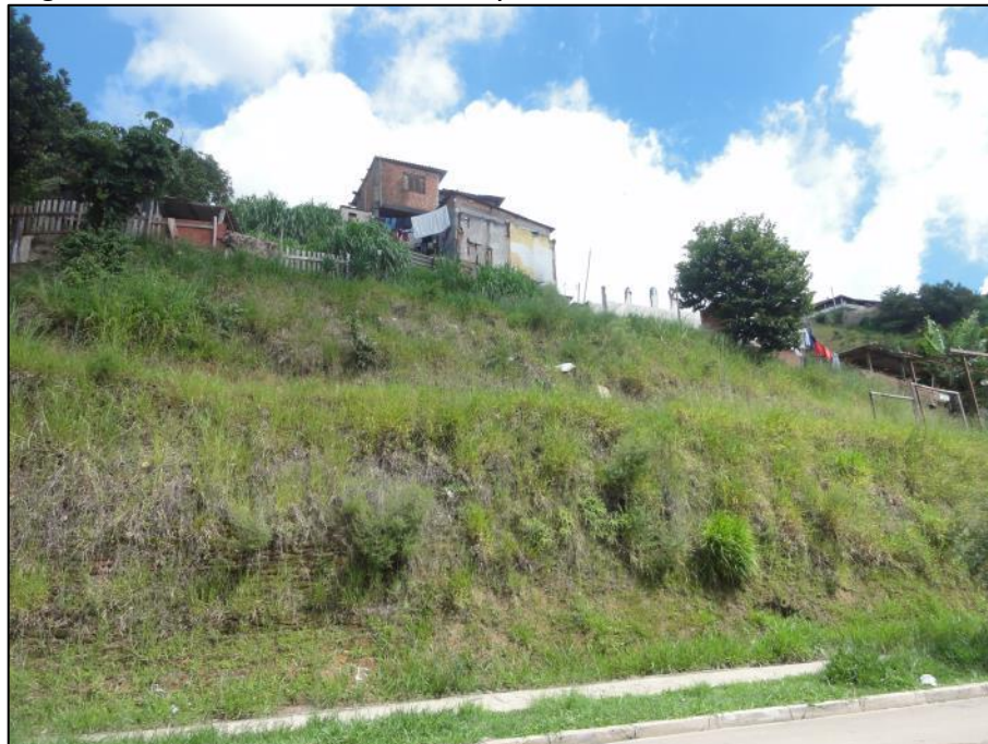
Figura 45 – Moradia situada no topo do talude de corte.
