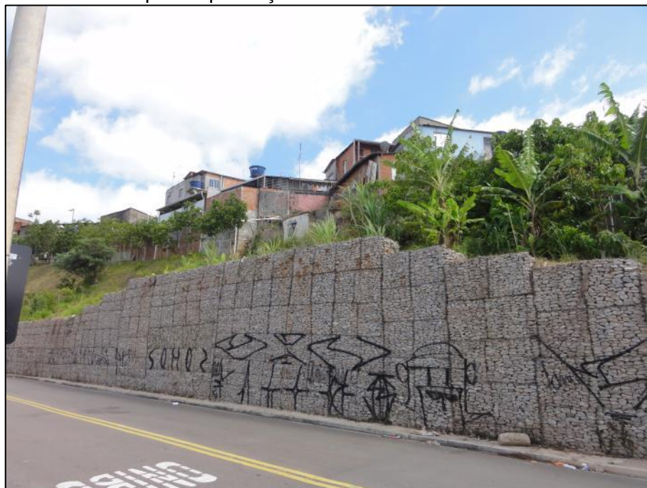
Figura 49 – Vista do muro de contenção de gabião. Notar as moradias no topo e a plantação de bananeiras.
