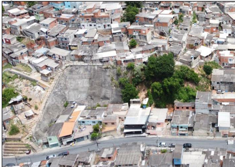
Figura 51 – Vista do talude com concreto jateado.
