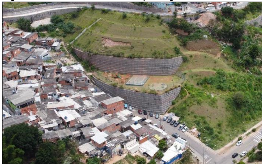
Figura 48 – Vista do muro de contenção de gabião.
