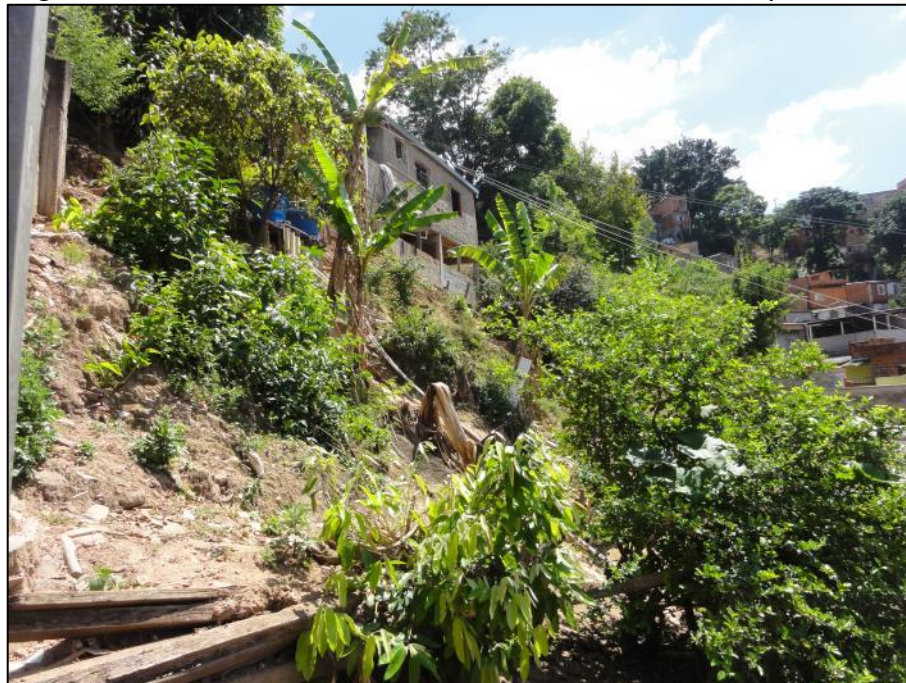
Figura 72 – Detalhe do talude de corte com moradia no topo.
