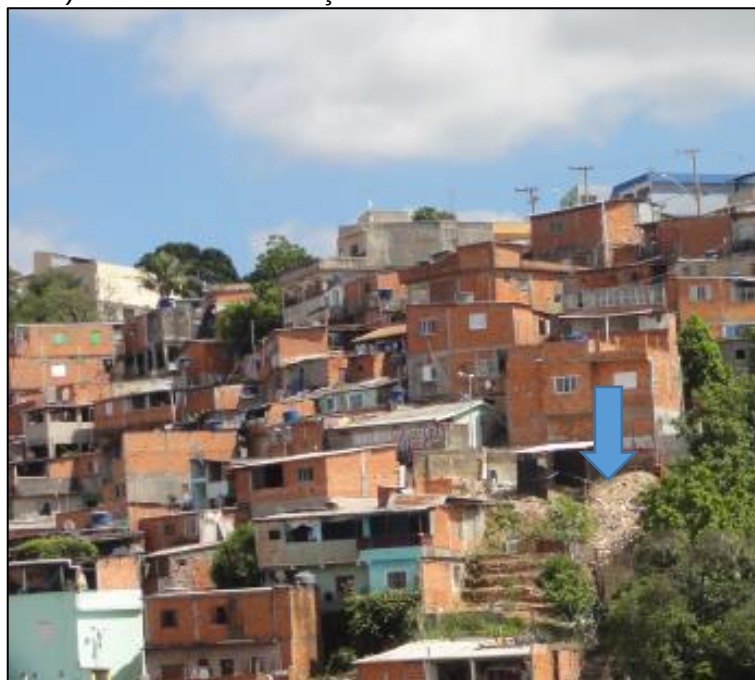
Figura 46 – Depósito de entulho em talude de corte (Seta Azul). Notar a consolidação do setor.
