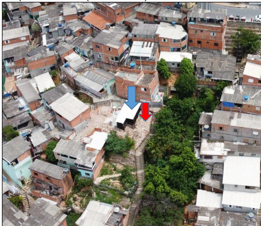
Figura 53 – Reocupação com moradia de madeira (Seta Azul). Notar o depósito de entulho (Seta Vermelha).
