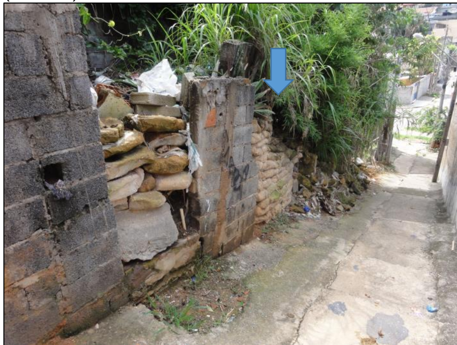
Figura 52 – Vista lateral de contenção em solo-cimento ensacado (Seta Azul).
