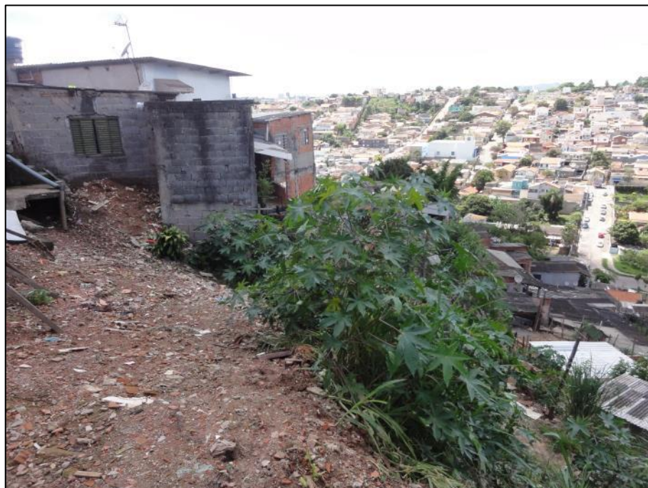
Figura 56 – Moradia com baixo padrão construtivo em talude de aterro.
