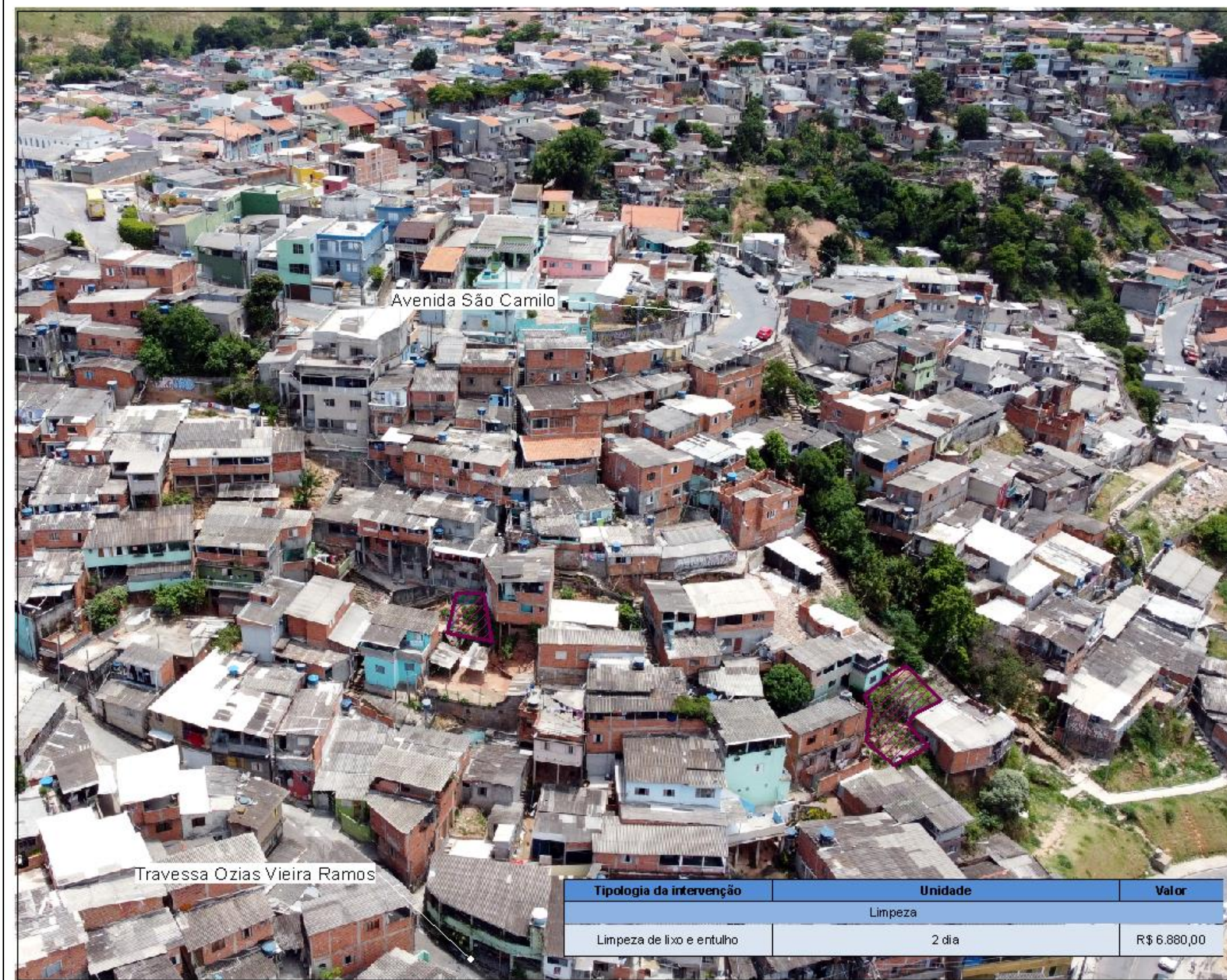
Figura 92 – Localização da intervenção estrutural e a sua tipologia em imagem oblíqua de Drone.
