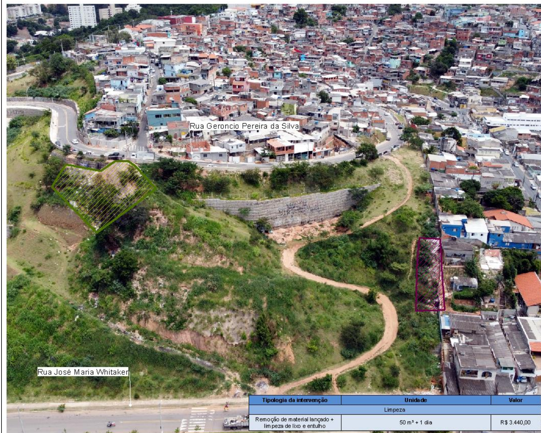
Figura 81 – Localização da intervenção estrutural e a sua tipologia em imagem oblíqua de Drone.
