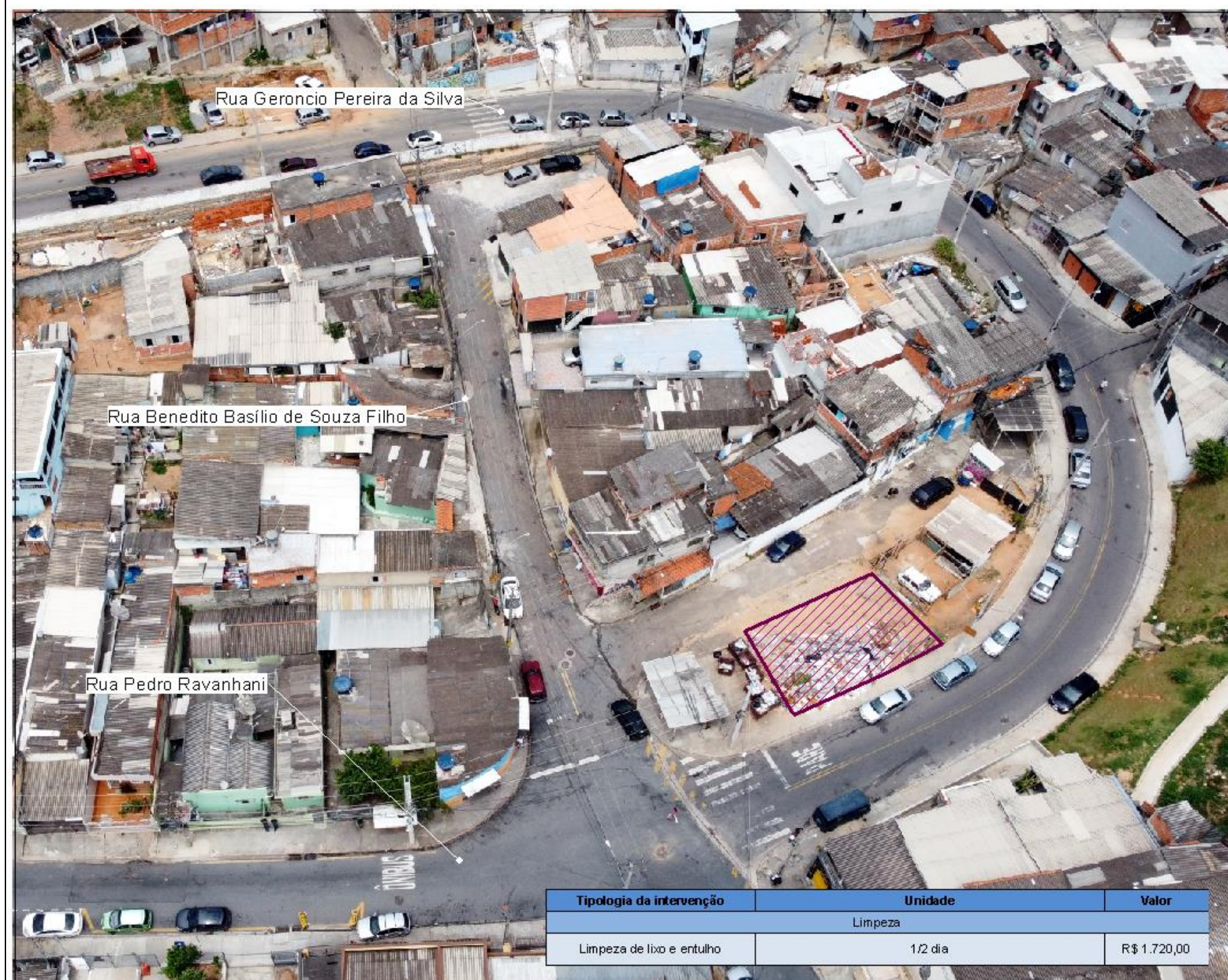
Figura 86 – Localização da intervenção estrutural e a sua tipologia em imagem oblíqua de Drone.
