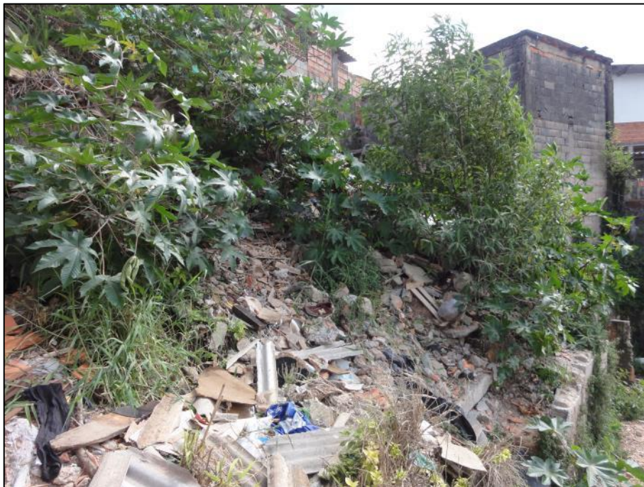
Figura 59 – Lixo e entulho lançados em patamar de casa desconstruída.
