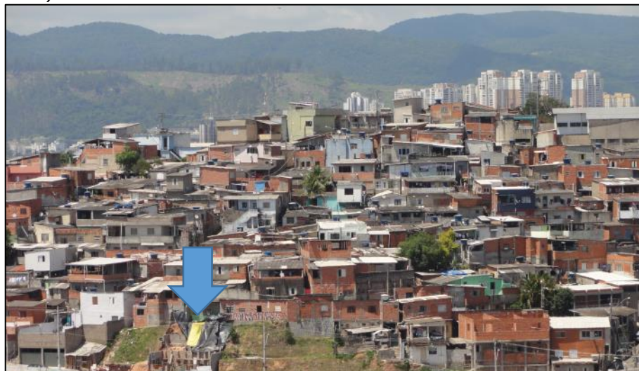
Figura 64 – Notar a lona protegendo a ruptura do talude (Seta Azul).
