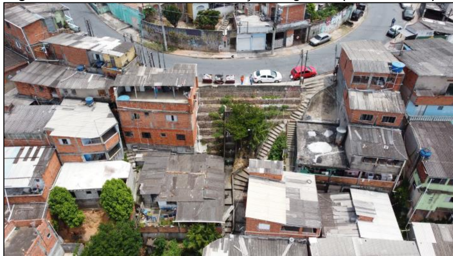
Figura 47 – Vista do muro de contenção de gabião (Viela do Pelé).
