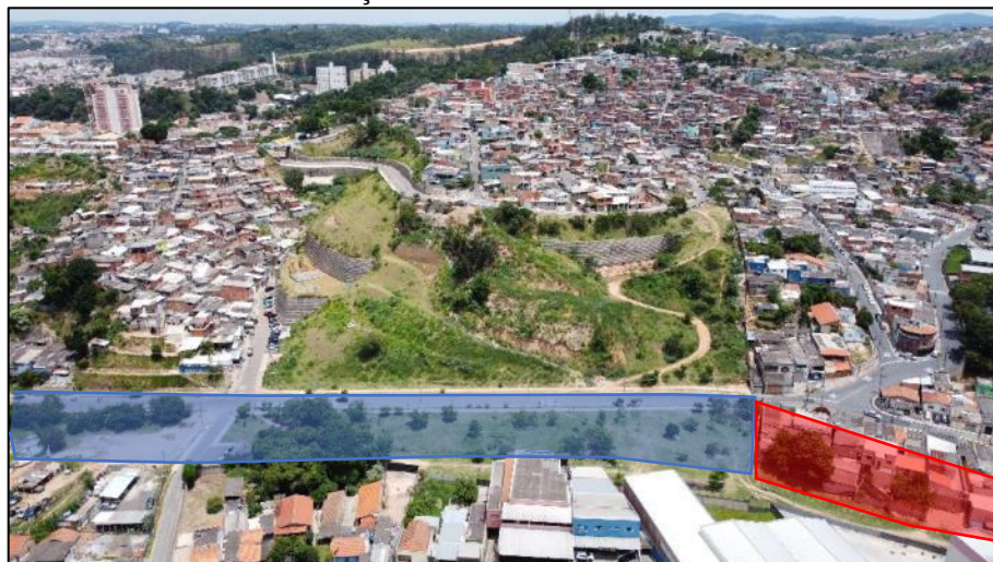
Figura 28 – Trecho onde houve remoção de residências, na APP do afluente do Rio Jundiaí (em azul) e ocupação em APP (vermelho) – trecho canalizado em seção fechada.
