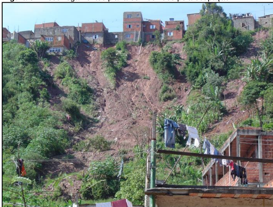
Figura 3 – Escorregamentos planares induzidos pela ocupação.
