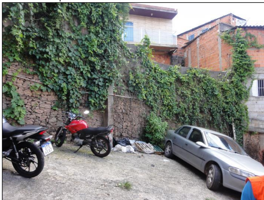
Figura 50 – Vista do muro de contenção de gabião. Notar as moradias no topo.
