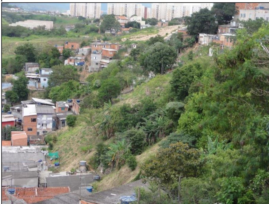
Figura 56 – Taludes de corte na base da encosta. Notar a proximidade das moradias a base do talude.
