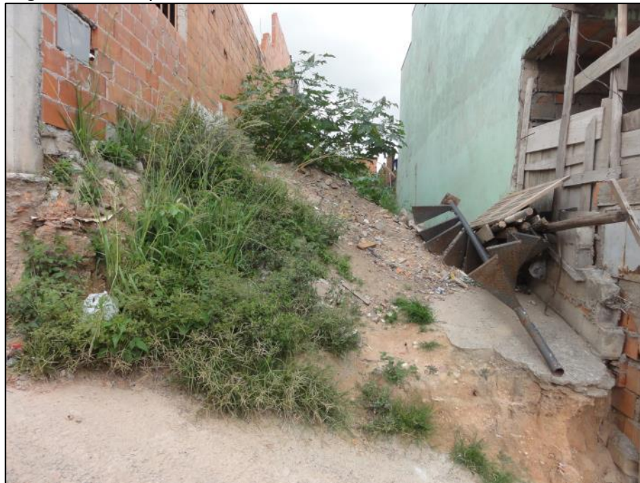
Figura 50 – Depósito de entulho.
