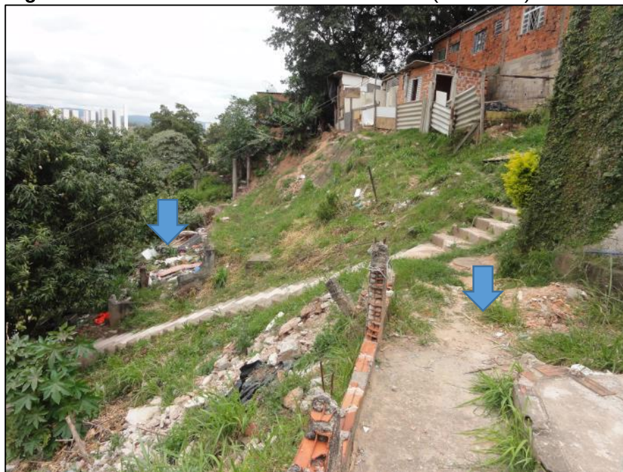
Figura 58 – Notar as moradias desconstruídas (Seta Azul).
