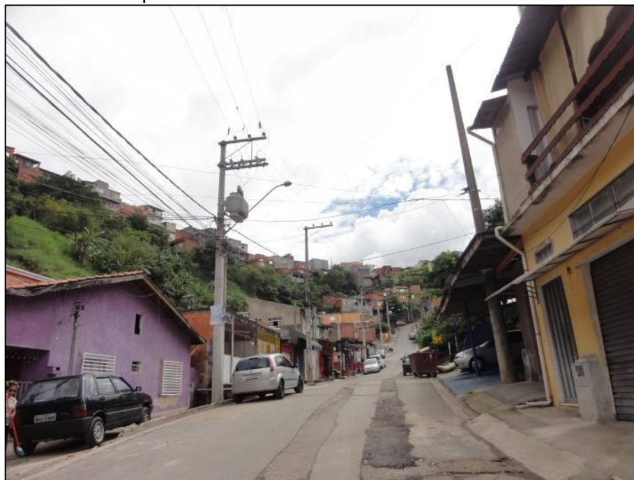
Figura 55 – Vista parcial do setor. Notar o padrão construtivo das moradias à esquerda da rua da Mina.
