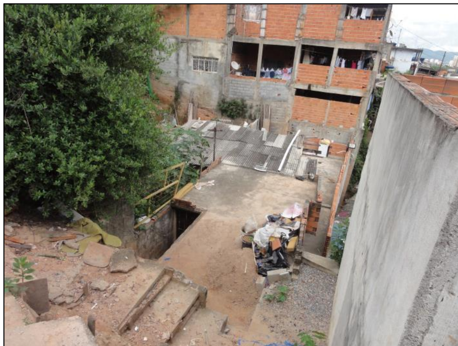
Figura 67 – Talude de corte ao lado esquerdo da que foi construída abaixo do nível da rua..
