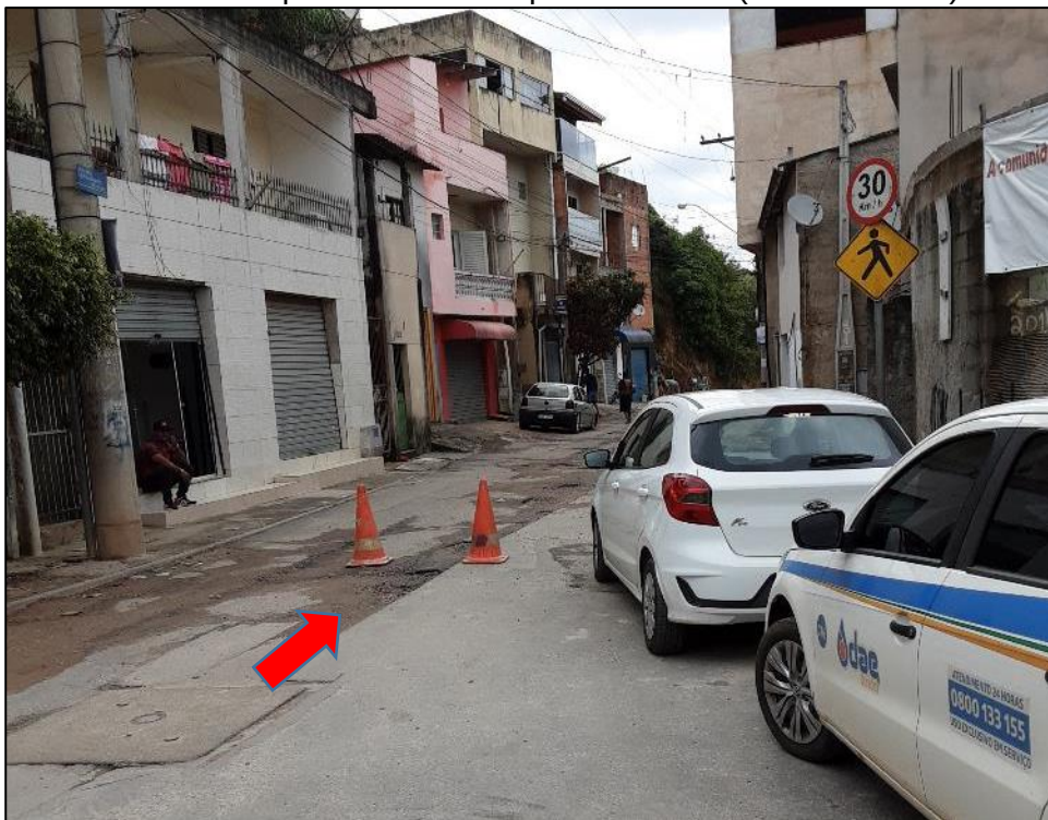
Figura 21 – Ampliação da rede de esgoto pelo DAE no trecho do assentamento incorporado ao município de Jundiaí (seta vermelha).
