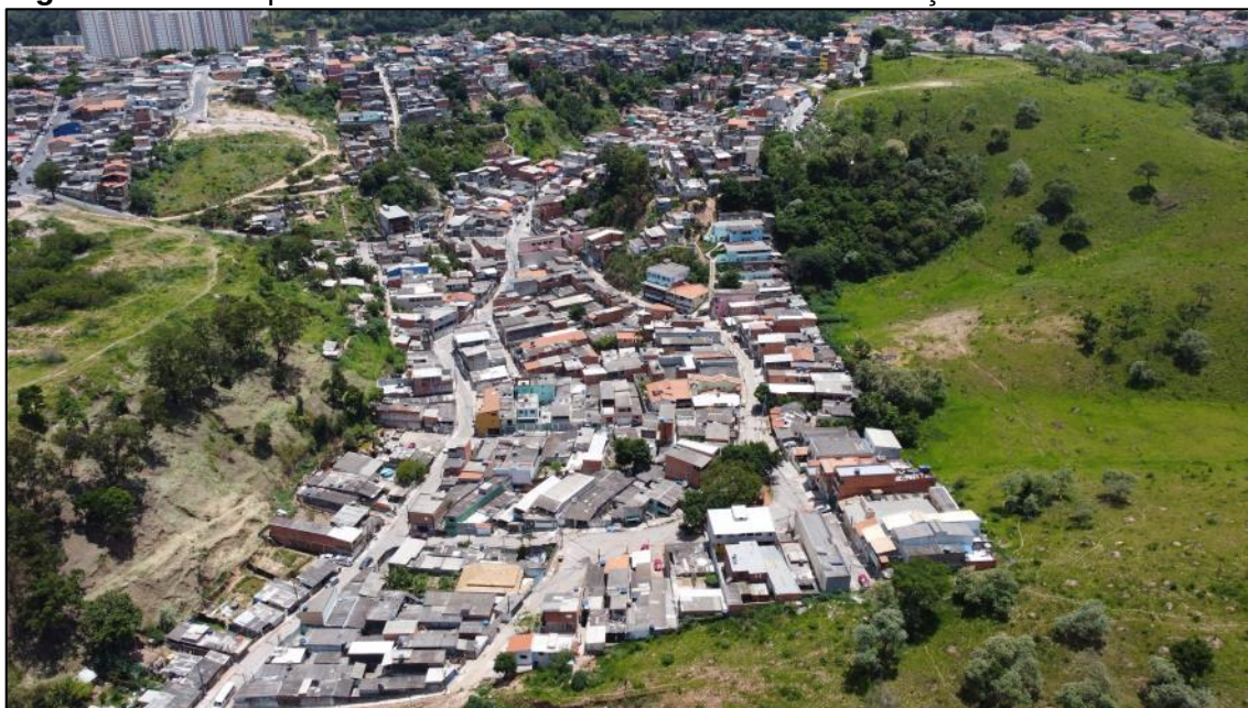
Figura 46 – Vista parcial do setor JUN-03-01. Notar a consolidação do setor.
