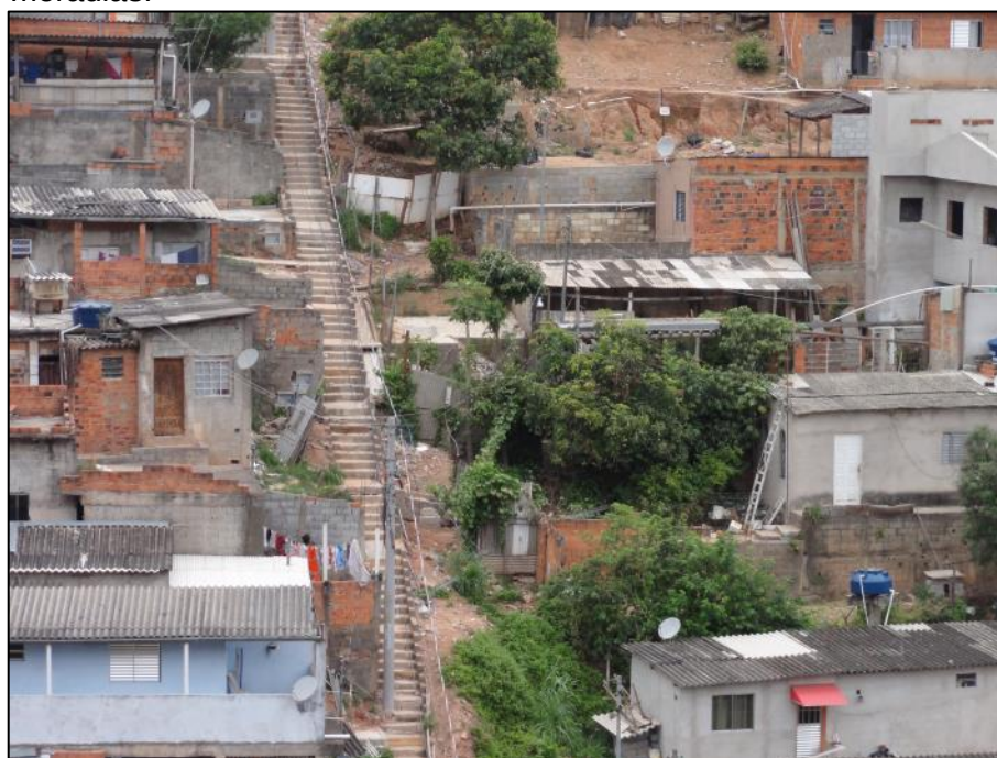
Figura 49 – Talude de corte com moradias no topo e base das moradias.
