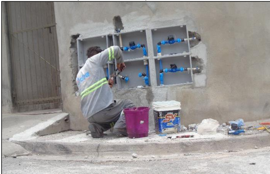
Figura 20 – Instalação de medidores de água no trecho do assentamento incorporado ao município de Jundiaí.
