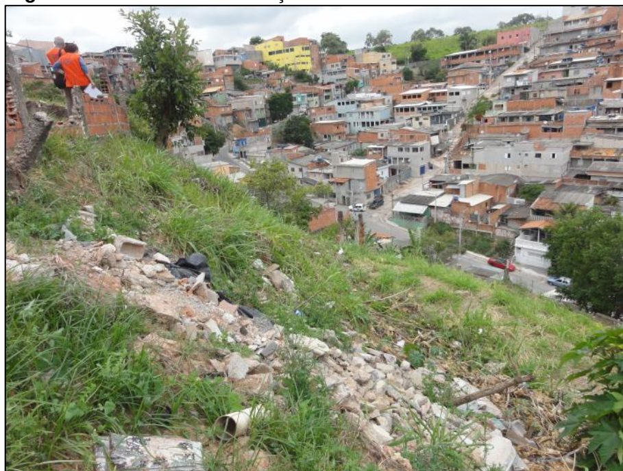
Figura 59 – Lixo e entulho lançado na encosta.
