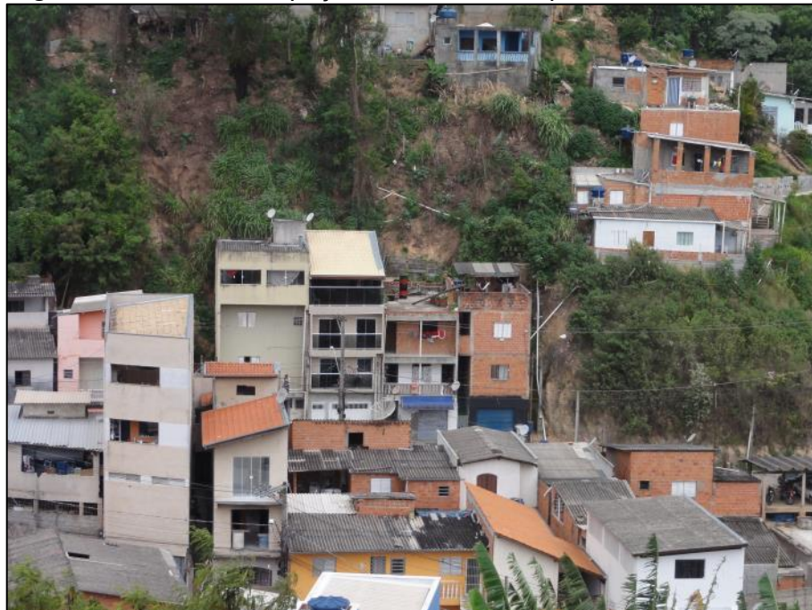
Figura 70 – Notar a ocupação na base e no topo do talude..
