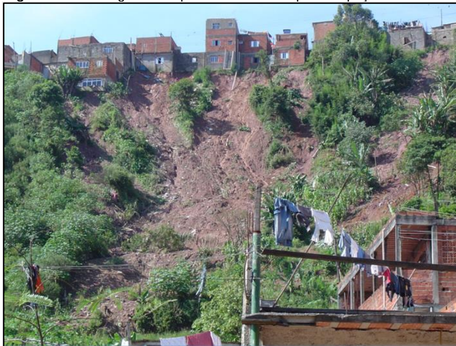
Figura 3 – Escorregamentos planares induzidos pela ocupação.
