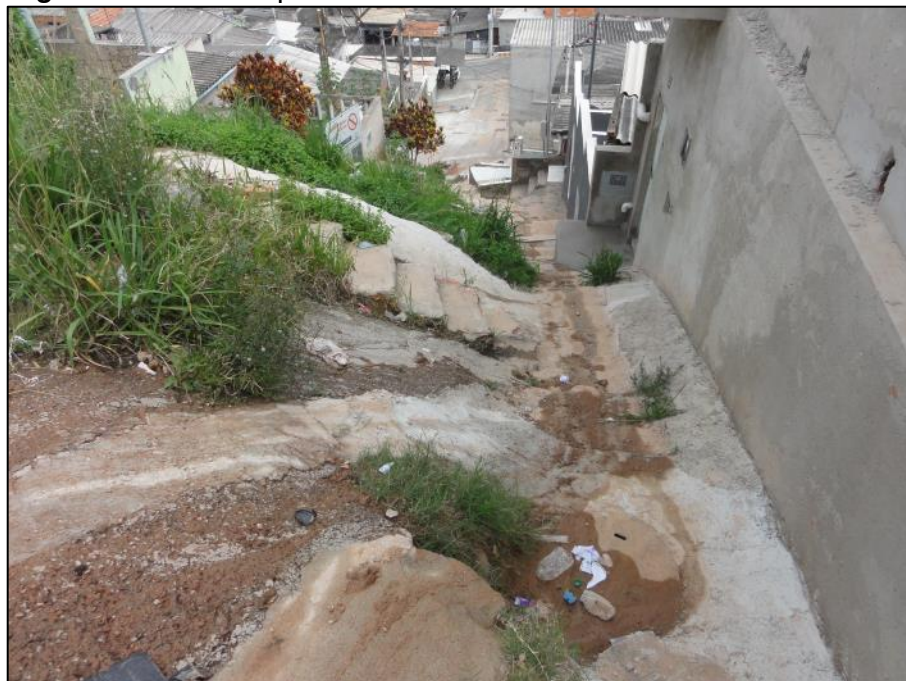
Figura 51 – Notar a precariedade do acesso.
