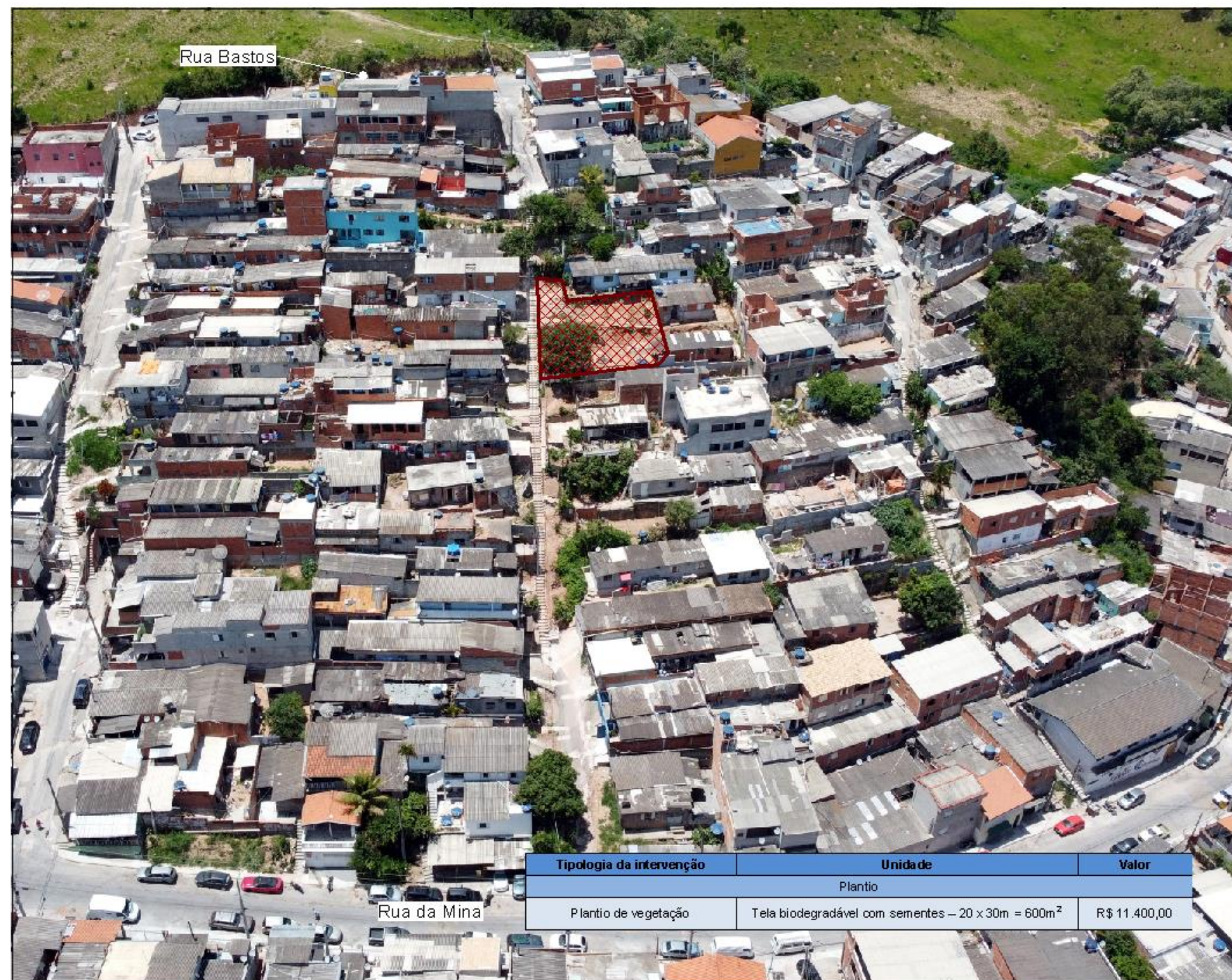
Figura 80 – Localização da intervenção estrutural e a sua tipologia em imagem oblíqua do Drone.
