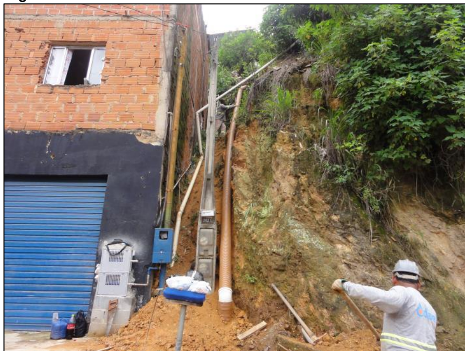
Figura 71 – Notar a altura do talude de corte.
