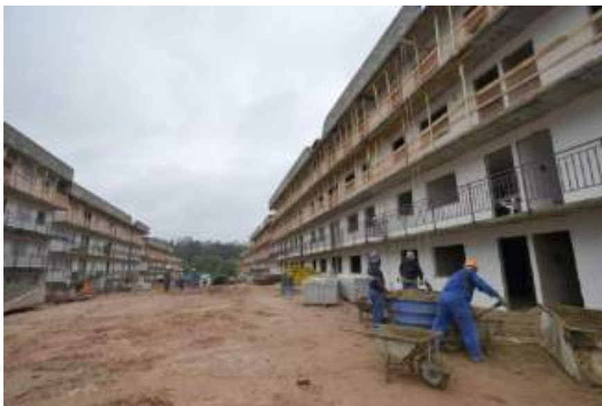
Figura 4.1. Empreendimento Jardim São Camilo em obras – reassentamento
