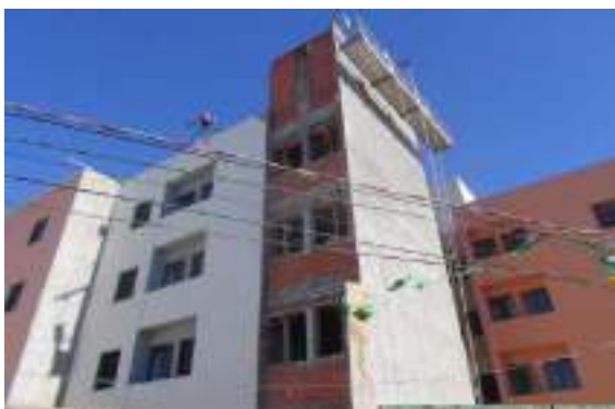
Obras do projeto Vila Ana
