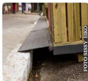
Placa metálica articulada sobre a sarjeta, para facilitar a manutenção
