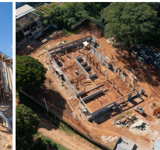
UBS Rio Acima: 39,30% executada
