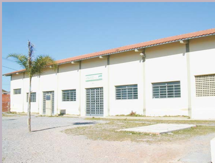
Vista do Centro Comunitário Fazenda Grande
