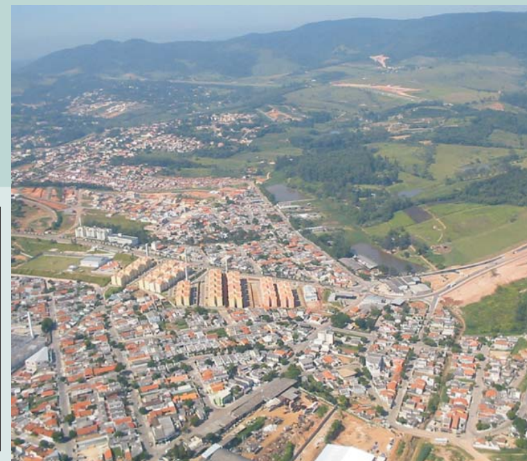
Vista parcial do Bairro Vila Alvorada
