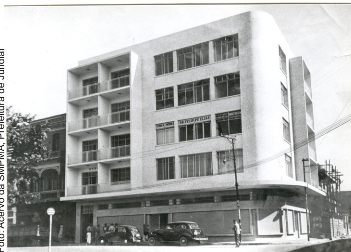
O edifício abriga lojas no térreo e escritórios nos pavimentos superiores.
