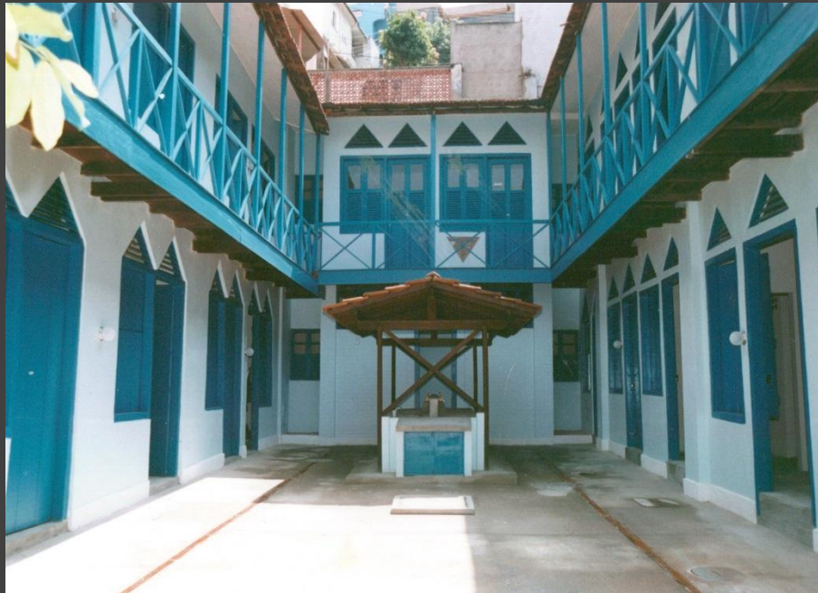
DEPOIS DA OBRA
