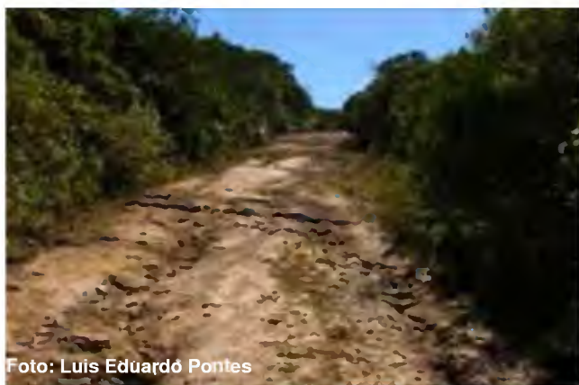
Foto: Luis Eduardó Pontes 3.84. Problemas de erosão.
