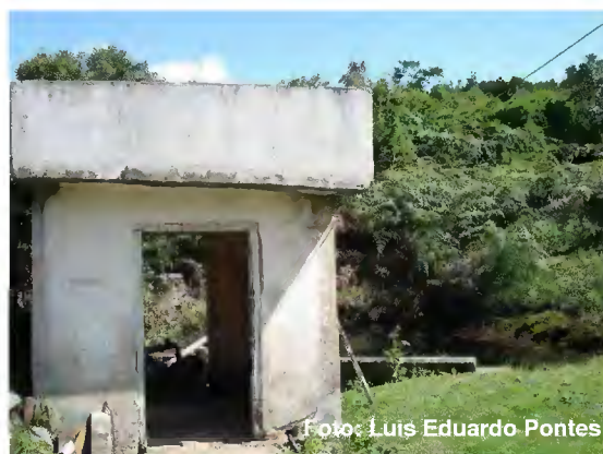
Foto 3.35. Rede de distribuição de água dentro do loteamento “Serras da Ermida”.
