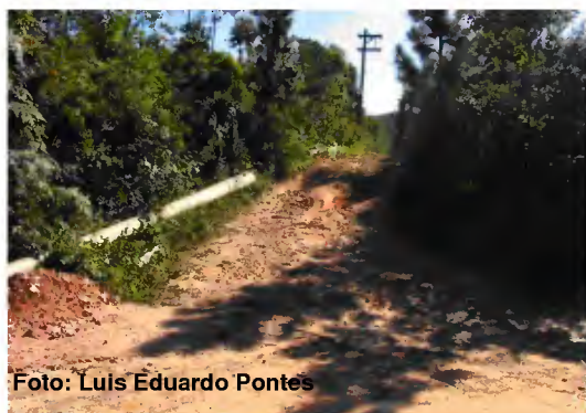
Foto 3.100. Obras na trilha.
