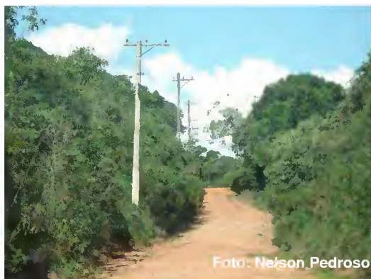
Foto 3.32. Ruas dentro do loteamento “Serras da Ermida” e postes com fiação elétrica.
