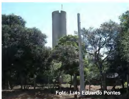
Foto 3.34. Instalação para captação de água dentro do loteamento “Serras da Ermida”.
