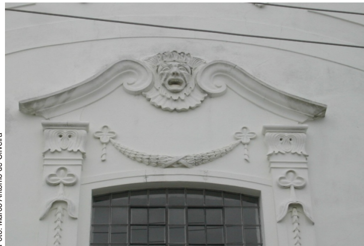
Detalhe da moldura da esquadria.
