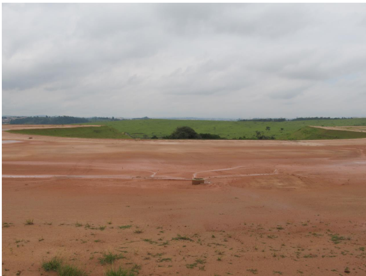
Foto 15 – Vista Geral do Terreno da Av. Projetada / Av. Um
