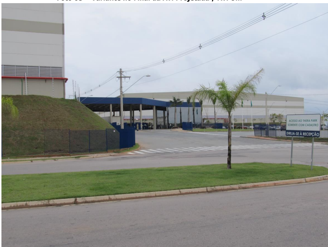
Foto 06 – Instalações da THERA defronte à Av. Projetada / Av. Um
