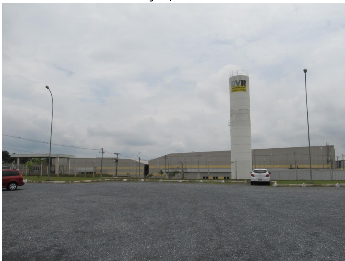
Foto 10 - Instalações da DVR defronte a Av. Marginal / Lateral – Av. José A Oliveira
