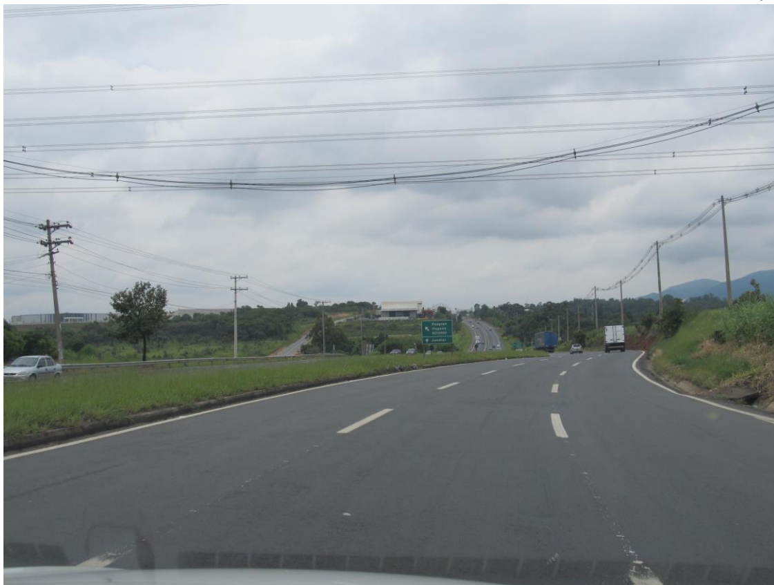
Foto 13 - Retorno Operacional do Km 4 da SP-066
