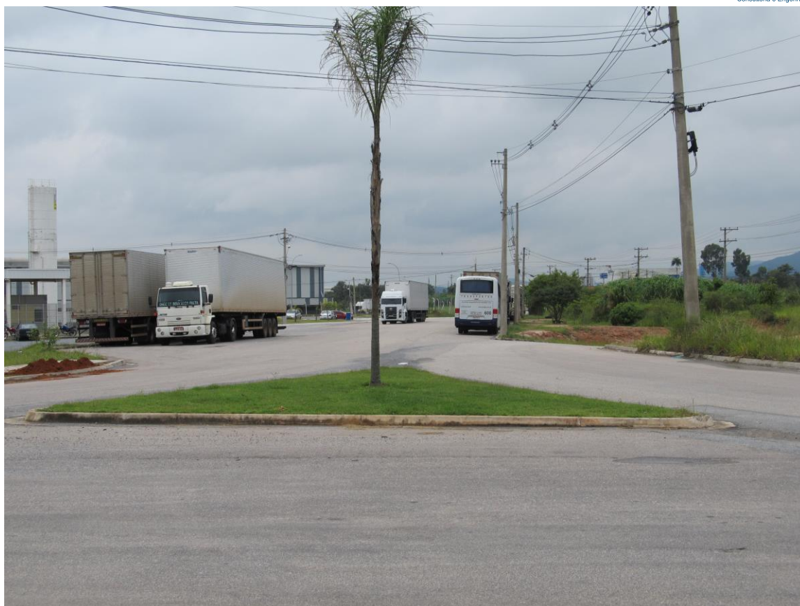
Foto 07- Vista da Av. Marginal / Lateral a SP-066 – Av. José Alves de Oliveira
