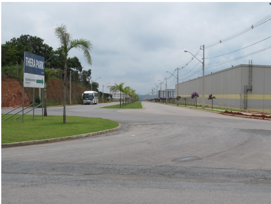
Foto 23 – Início da Via Projetada / Av. 1 junto à Via Marginal / Lateral
