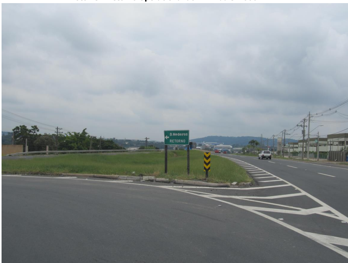
Foto 14 - Retorno Operacional do Km 4 da SP-066
