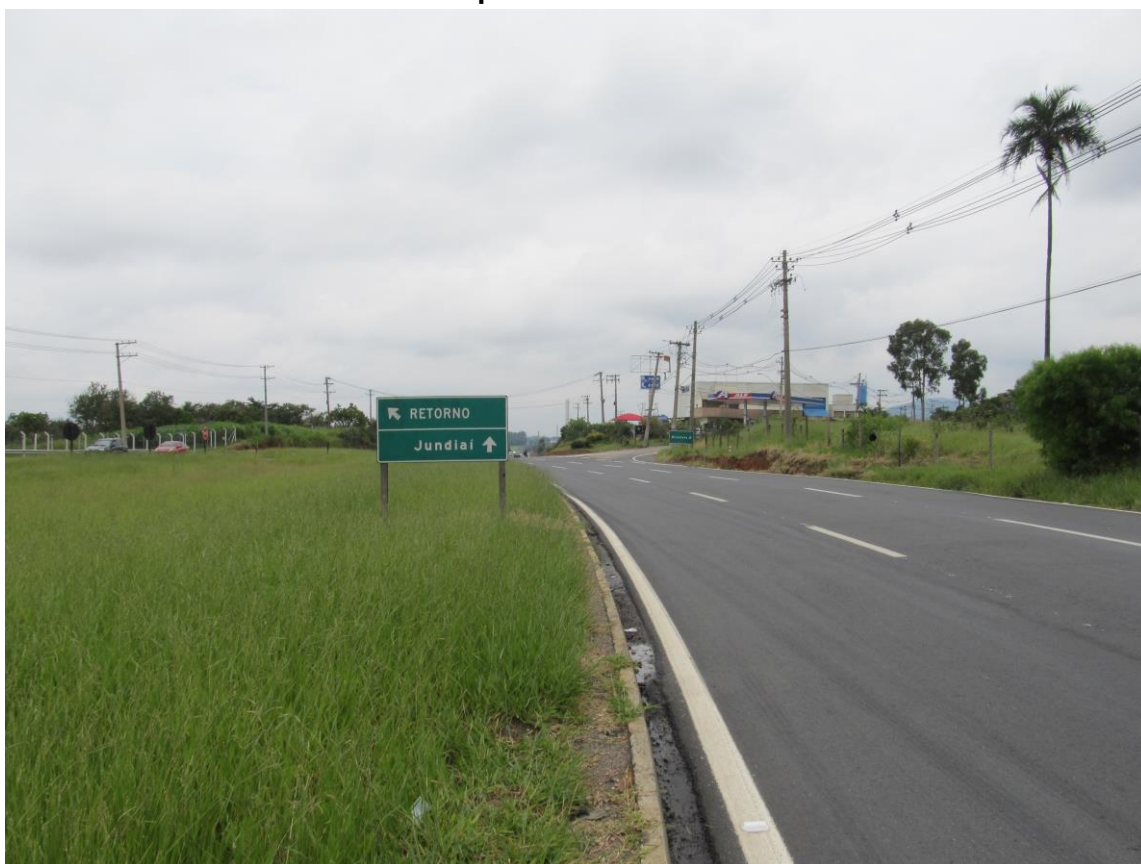
Foto 12- Retorno Operacional do Km2 da SP-066
