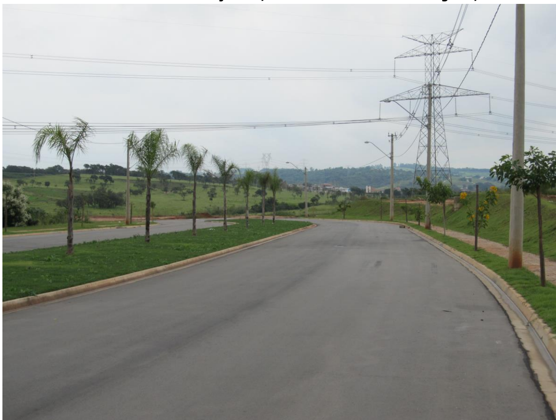
Foto 04 – Término da Av. Projetada / Av. Um sob Rede de Alta Tensão
