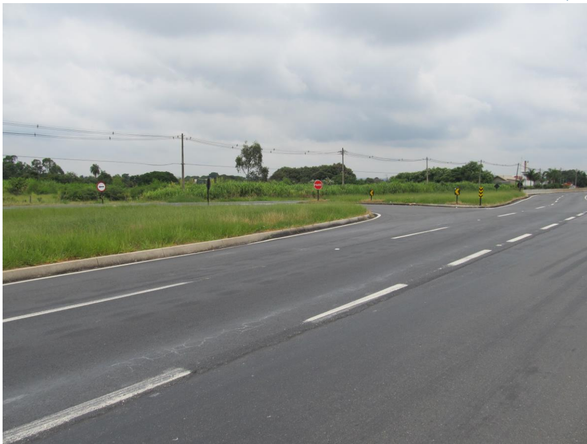
Foto 11- Retorno Operacional do Km2 da SP-066
