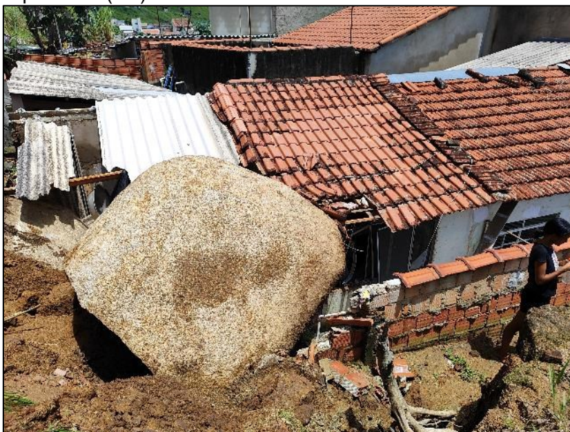
Figura 15 – Moradia atingida por bloco que rolou da encosta, Aparecida (SP).
