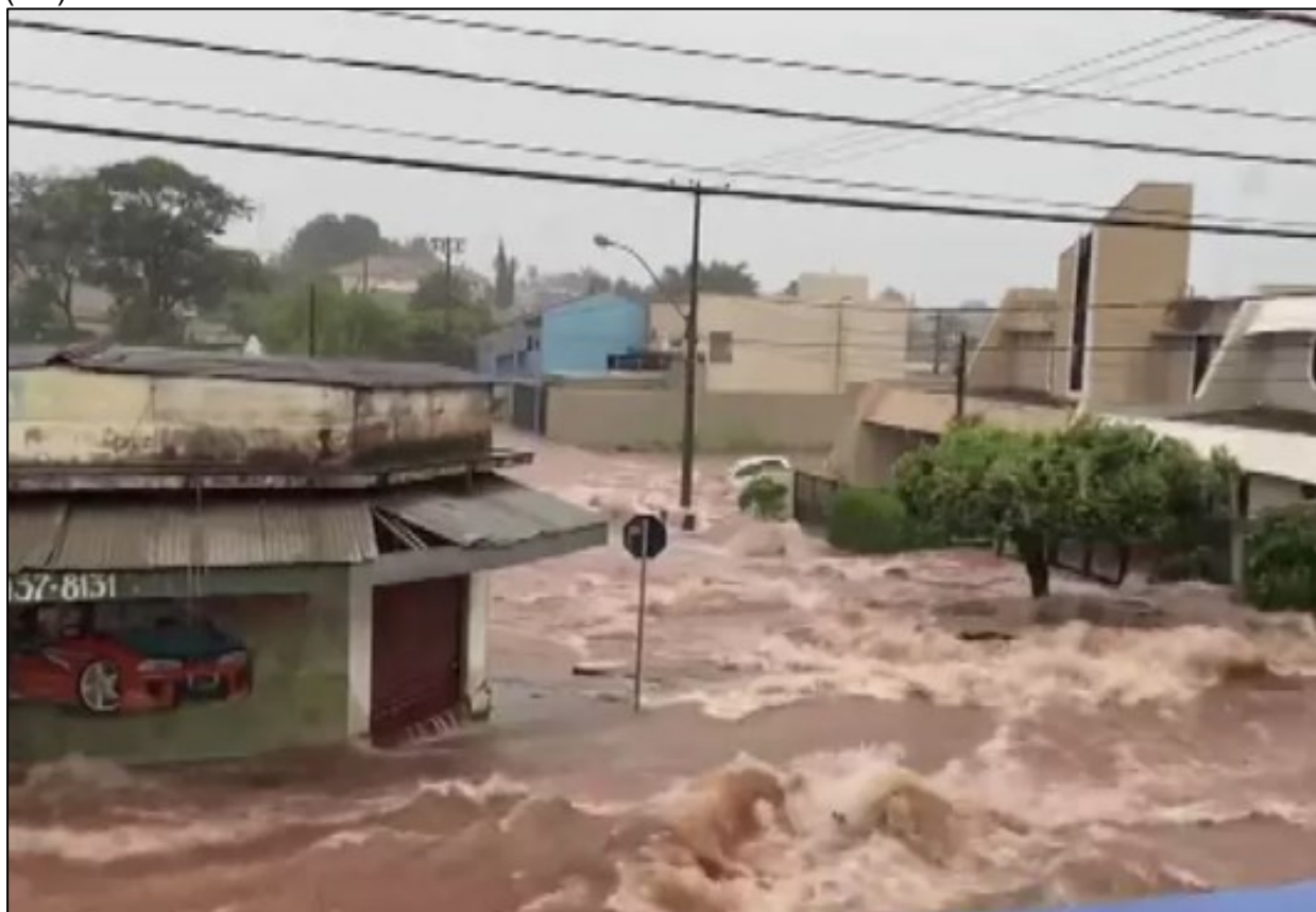
Figura 24 – Escoamento concentrado das águas pluviais, a enxurrada, município de Barretos (SP).
