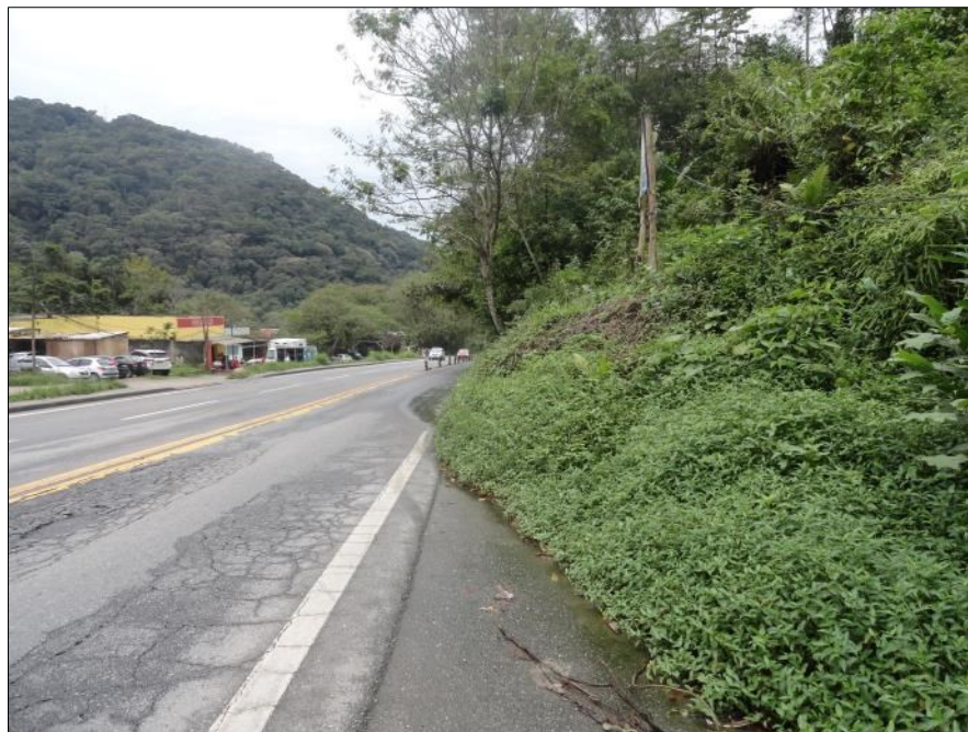
Figura 3 – Vista parcial do depósito de tálus existente no bairro de Juquehy, em São Sebastião, SP, que está em movimento, afetando a rodovia.
