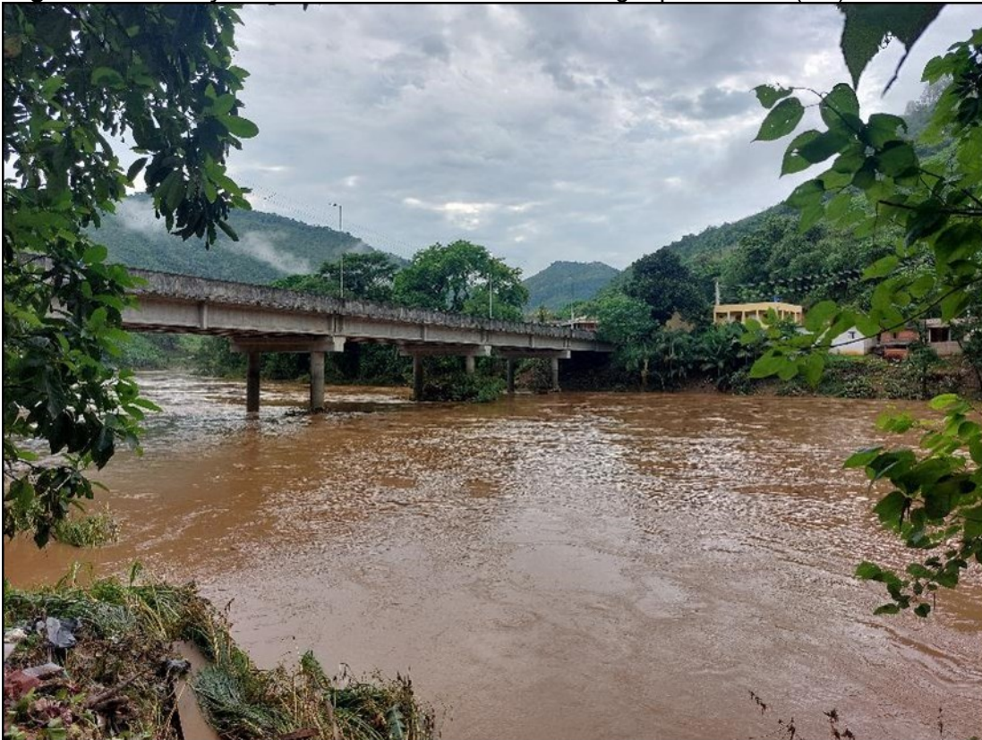
Figura 20 - Situação de enchente no rio Ribeira do Iguape, Ribeira (SP).
