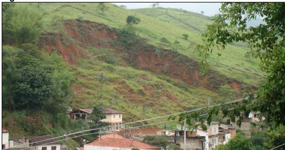
Figura 8 – Deslizamento circular ou rotacional
