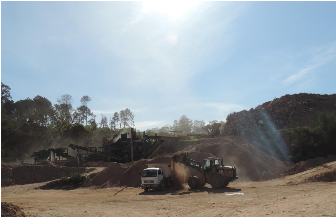
Figura 11: Material de resíduo da construção civil beneficiado - GERESOL.
